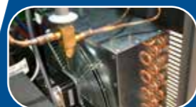
CONDENSATORE SOVRADIMENSIONATO per prestazioni ottimali alle alte temperature.
